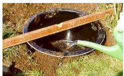
Шламу таз з водою. Перевірте кілька разів за допомогою спиртового рівня, правильне положення тазу.
