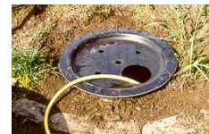
Fyll bassängen med vatten. Kontrollera igen att bassängen är väl slammars och kan inte längre flyttas. Sätt på locket och placera den stora öppningen på en lättåtkomlig plats.
