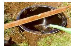
Le bassin de boues avec de l'eau. Arrivée à plusieurs reprises au moyen d'un niveau à bulle, la position correcte du bassin.
