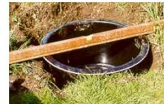
Ridicați de pe prima gaură pentru bazin. Introduceți toate în jurul valorii de excavare la aproximativ 5 cm, astfel încât să puteți alinia cu ușurință pelvis. Apoi, aliniați pelvis cu ajutorul unei nivele cu precizie. Umplerea golurilor rămase cu pământ din nou.
