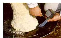
Așezați caracteristică de apă pe copertă și a alerga conexiunea furtunului înapoi în gaura din capacul în castron (deschidere mare a pompei). Acum, conectați pompa și introduceți-l în bazin umplut cu apă.
