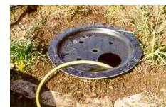
Remplissez le bassin avec de l'eau. Vérifiez encore une fois que le bassin est bien mis en suspension et ne peut plus être déplacé. Mettre le couvercle et placez la grande ouverture dans un endroit facilement accessible.
