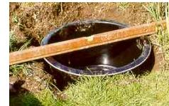
Heben Sie zuerst das Loch für das Becken aus. Geben Sie rundum beim Aushub ca. 5 cm zu, damit Sie das Becken bequem ausrichten können. Richten Sie dann das Becken mithilfe einer Wasserwaage genau aus. Verfüllen Sie die verbliebenen Hohlräume wieder mit Erde.
