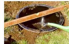
El depósito de lodo con agua. Compruebe varias veces por medio de un nivel de burbuja, la posición correcta de la pelvis.
