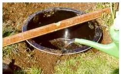
Slammet bassin med vand. Check flere gange ved hjælp af et vaterpas, den korrekte position af bækkenet.
