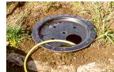
Γεμίστε το δοχείο με νερό. Ελέγχτε και πάλι ότι η λεκάνη είναι καλά πολτοποιείται και δεν μπορεί πλέον να μετακινηθεί. Τοποθετήστε το καπάκι και τοποθετήστε το μεγάλο άνοιγμα σε ένα εύκολα προσβάσιμο μέρος.
