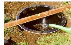
Bazinul nămol cu apă. Verificați de mai multe ori prin intermediul unui nivel de spirit, poziția corectă a bazinului.
