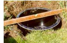
Σηκώστε την πρώτη τρύπα για τη λεκάνη. Εισάγετε όλες γύρω από την ανασκαφή με 5 cm έτσι ώστε να μπορείτε εύκολα να ευθυγραμμίσει την πύλο. Στη συνέχεια, ευθυγραμμίστε τη λεκάνη χρησιμοποιώντας ένα αλφάδι με ακρίβεια. Πλήρωση τα υπόλοιπα κενά με τη γη και πάλι.
