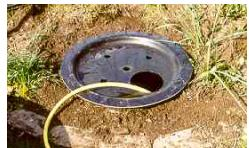
Vul het bassin met water. Controleer opnieuw of het bekken goed gesuspendeerd en kan niet meer worden bewogen. Doe de deksel en plaats de grote opening in een gemakkelijk toegankelijke plaats.
