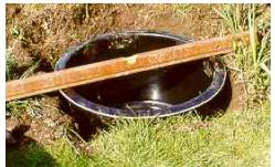
Levante o primeiro buraco para a bacia. Digue todo o escavação de cerca de 5 cm de modo que você pode facilmente alinhar a pélvis. Então, alinhar a pelve usando um nível de bolha de precisão. Preenchendo os vazios restantes com a terra novamente.
