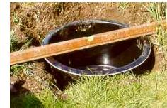
Levante el primer hoyo de la cuenca. Entre todos alrededor de la excavación de unos 5 cm para que pueda adaptar fácilmente a la pelvis. A continuación, alinee la pelvis mediante un nivel de burbuja de precisión. Llenar los vacíos que quedan en la tierra otra vez.
