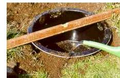
Slammet bassäng med vatten. Kontrollera flera gånger med hjälp av ett vattenpass, den korrekta positionen av bäckenet.
