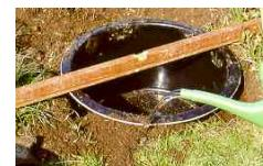
Шлама таз с водой. Проверьте несколько раз с помощью спиртового уровня, правильное положение таза.
