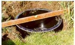
Løft det første hul for bassinet. Indtast hele udgravingen til omkring 5 cm, så du nemt kan justere bækkenet. Derefter justere bækken ved hjælp af et vaterpas præcist. Påfyldning de resterende hulrum med jord igen.
