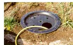
Befüllen Sie das Becken mit Wasser. Kontrollieren Sie nochmals, dass das Becken gut eingeschlämmt ist und sich nicht mehr bewegen lässt. Legen Sie den Deckel auf und positionieren Sie die große Öffnung an einer leicht zugänglichen Stelle.
