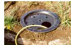
Llene el recipiente con agua. Comprobar de nuevo que la cuenca se formó una suspensión espesa y así ya no se puede mover. Ponga la tapa y coloque la abertura grande en un lugar fácilmente accesible.
