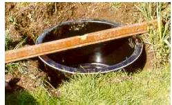
Til het eerste gat voor het bekken. Voer rondom de opgraving tot ongeveer 5 cm, zodat u gemakkelijk kunt uitlijnen het bekken. Breng daarna het bekken met behulp van een waterpas nauwkeurig. Het vullen van de resterende vides met aarde weer.
