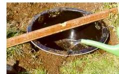
Schlümmen Sie das Becken mit Wasser ein. Kontrollieren Sie mehrmals mittels einer Wasserwaage die korrekte Position des Beckens.
